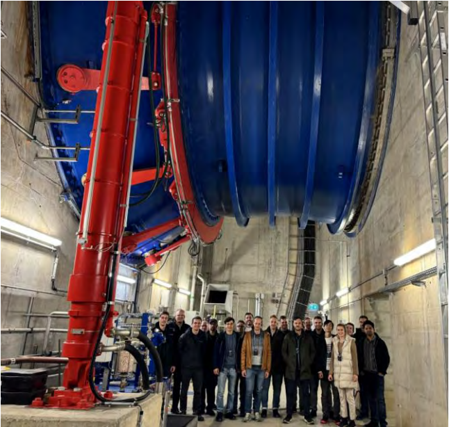
Bild: Im Inneren des Rheinkraftwerks Iffezheim
